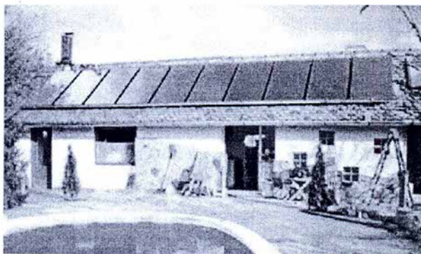
A kollektorok a családi ház melléképületének tetőfelületén helyezkednek el. A tetőhéjalás régi hódfarkú cserép, melyre a napkollektorokat alumínium szerelőkeret segítségével megbízhatóan, esztétikusan szerelték föl.
