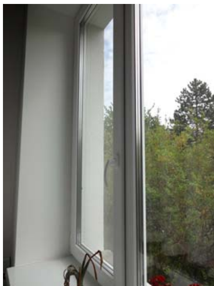
Nyílászáró 3 rétegű üvegezéssel
