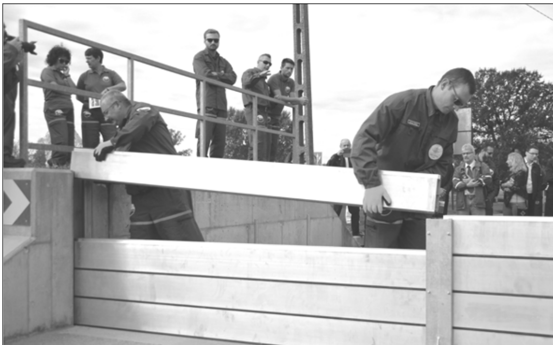
Az Únyi pataknál a próba során egy 80 cm magas, 7,75 méter széles falat építettek a kulisszanyílásba.
