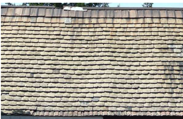
Égetett agyag - cserép tetőfedések
