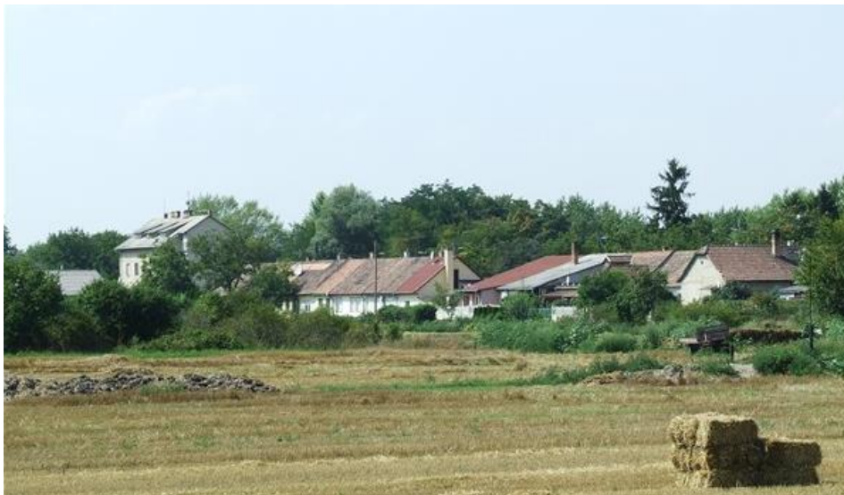
Táti Depo a 10-es főút felől
