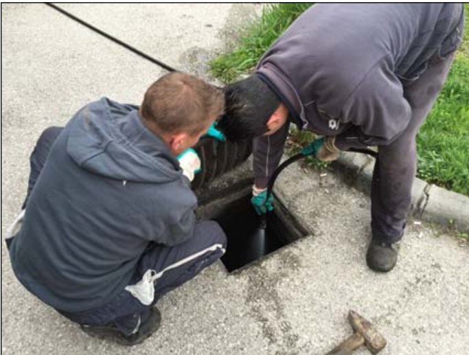
Fő street - flushing channel
