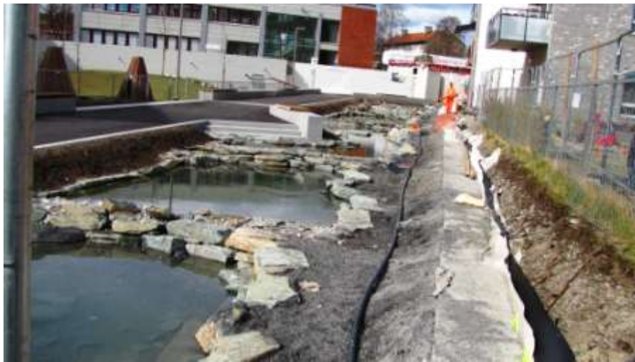
6. kép: Patakmeder kiépítése a lakóházak között, Aarvollammen városrész, Oslo
