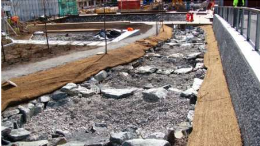
7. kép: Patakmeder kiépítése a városban, Aarvollammen városrész, Oslo
